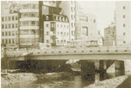
田川に架かる「宮の橋」
