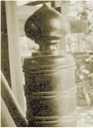
本殿勾欄の擬宝珠
